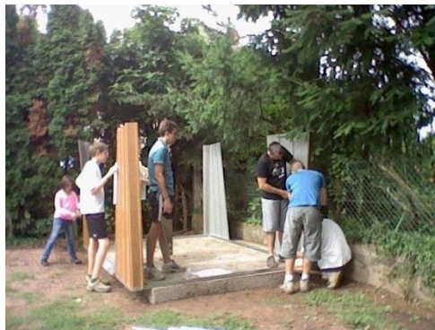
Montage de la nouvelle cabane
